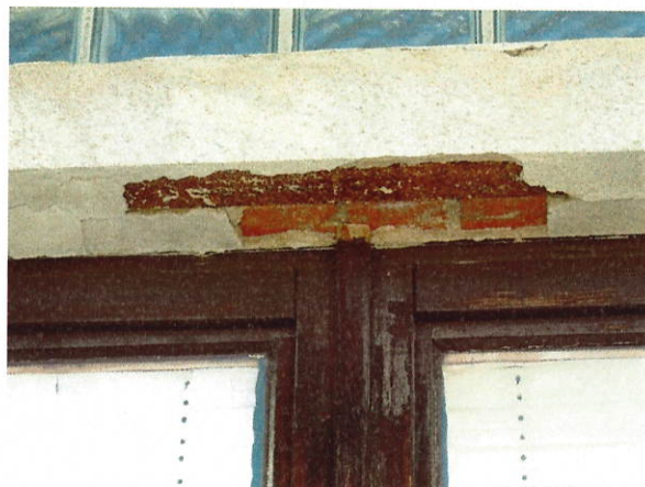
č. 20 – 23 detaily poškození fasády v úrovni atiky a okenních nik
