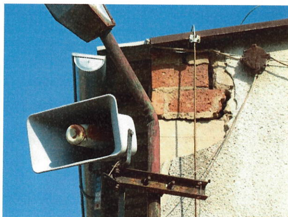
č. 20 – 23 detaily poškození fasády v úrovni atiky a okenních nik
