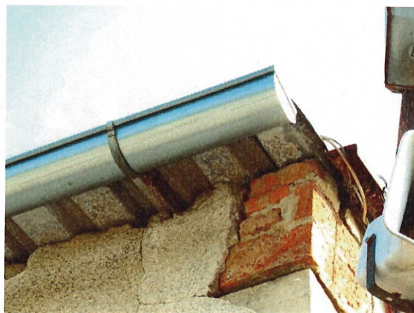
č. 8 – 9 Detaily spojení sedlové střechy se zdivem atiky na průčelích
